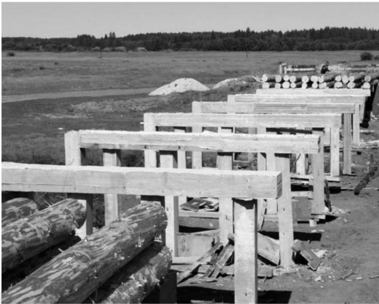
В нынешнем году будет отремонтирован мост в селе Скородумском. Его стоимость составит порядка 12 миллионов рублей. Подрядная организация к работе приступила еще в мае. На сегодня установлены опоры моста, рабочие занимаются монтажом пролетного строения и подготовкой древесины.
